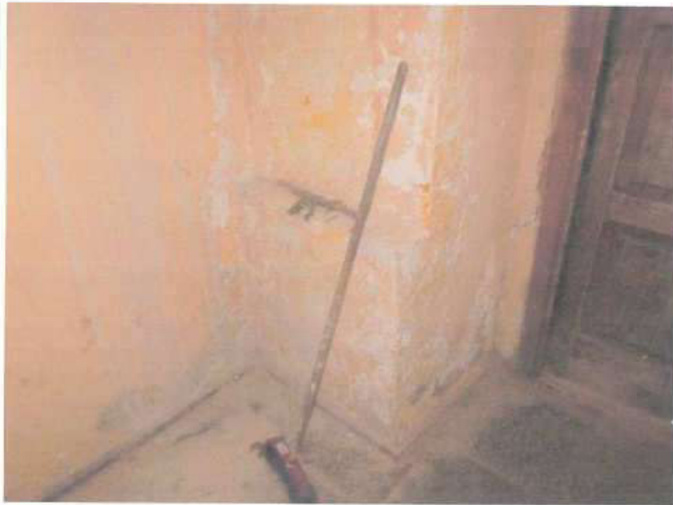
17. Įėjimo durys prie ašies „9“, vidaus mūras drėgnas W-15%, užterštas sulfatais ir chloridais.
