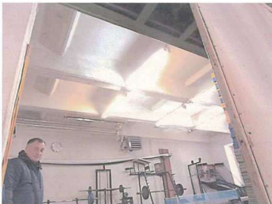
19. Dabartinės sporto salės, tarp ašių „9-11“ perdangos bendras vaizdas. Perdangos „PNKL“ tipo plokščių, atremtų į perdangas tarp ašių „9-11“.
