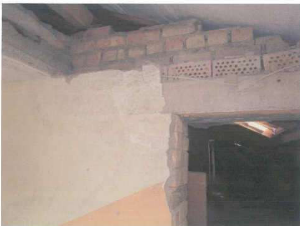
12. Laiptinės prie ašies „6“, vaizdas ties iškiršta anga. Laiptinė rekonstruotina, keistina angos vieta. Matosi surenkama gelžbetoninė sąrama virš angos. Anga nepakankamo aukščio, rekonstruotina.
