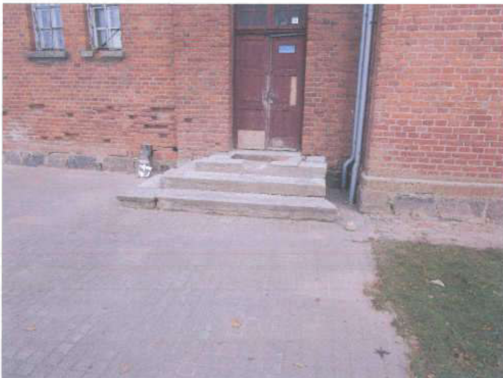
18. Įėjimo durys iš lauko pusės prie ašies „9“. Betoniniai lauko laiptai su grotelėmis blogos būklės -tvarkytini.
