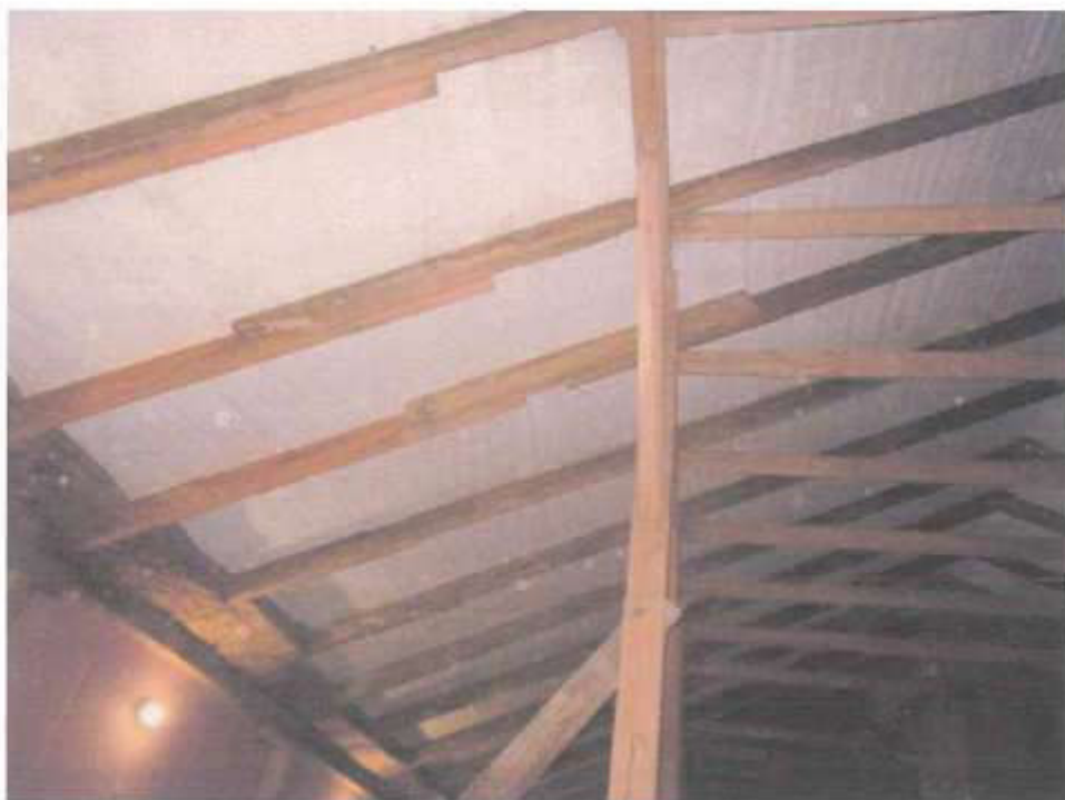
2.3.,8. Vaizdai pastogėje, tarp ašių „G – H“, „3 - 5“. Matoma paliekama „štulė“ su rygeliais, gegnių jungimo vietos, rygeliai. Iš apačios įrengta dangos difuzinė plėvelė. Siūloma „štulę“ palikti, obliuoti, apdoroti antipireniais, gegnes ir ilginius stiprinti.
