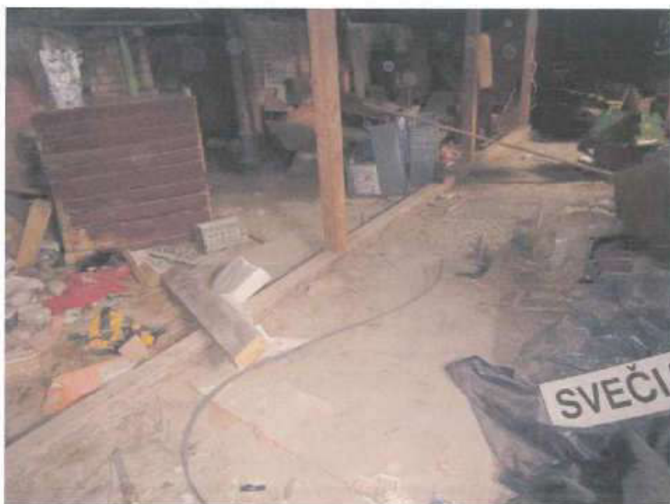
11. Vaizdas iš pastogės tarp ašių „6-9“. Matosi antros „štulės“, apatinis ilginis, įrengtas virš gelžbetoninės perdangos.
