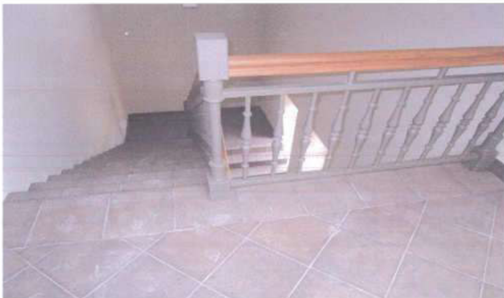
1. Laiptinė įrengta pirmame etape. Pakopos gelžbetoninės, aptaisytos plytelėmis. Turėklai ketaus, porankiai – mediniai. Būklė gera
