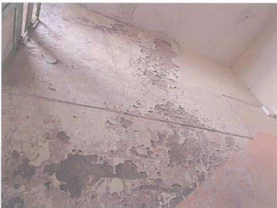
14.,15.,16. Laiptinė prie ašies „6“. Eroduotos sienos ašyje „6“. Sieną drėgna, 8-12%, ir užteršta tirpiomis druskomis sulfatais. Sieną sanuotina, laiptai rekonstruoti.
