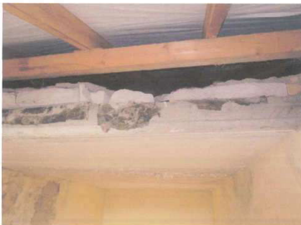
13. Laiptinės prie ašies „6“ perdangos konstrukcija. Perdanga surenkama „PTK“ tipo plokščių, apšiltinimas akyto betono, 14cm storio. Perdanga turi būti papildomai šiltinta.
