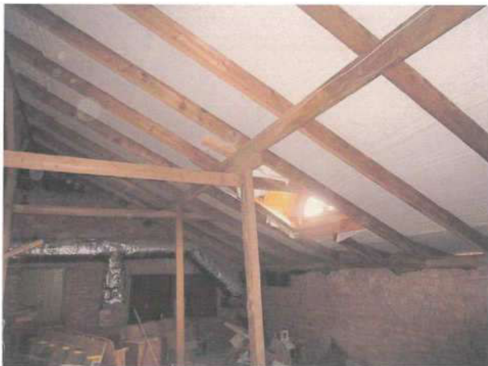
9., 10. Vaizdas iš pastogės, tarp ašių „6-9“. Matosi dvi „štulės“. Pirmą paliekama, antrą siūloma demontuoti, sustiprinus rėmą. Paliekamos „štulės“ ilginiai atrenkti į pobalkius. Paliekamą „štulę“ siūloma obliuoti, antipirenuoti.
