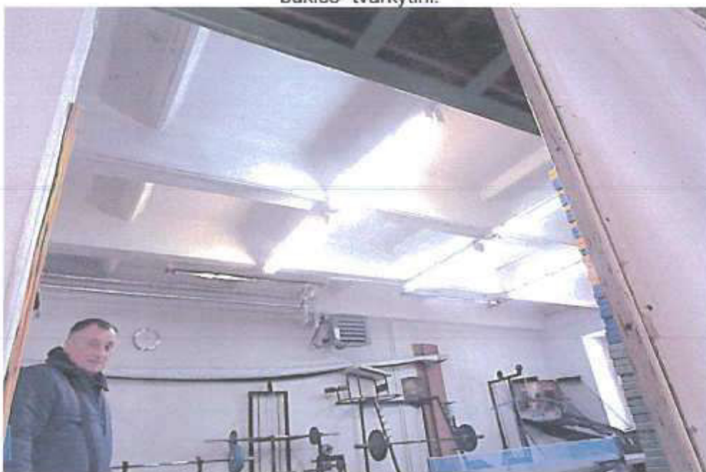
19. Dabartinės sporto salės, tarp ašių „9-11“ perdangos bendras vaizdas. Perdangos „PNKL“ tipo plokščių, atremtų į perdangas tarp ašių „9-11“.
